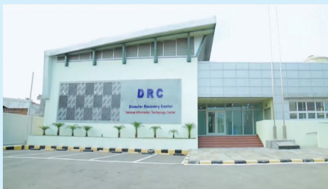
तस्बिर: हेटौंडा स्थित डाटा रिक्भरी सेन्टरमा FCGO Data Center Relocation गरिएको
